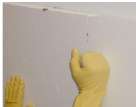
Pressionar os painéis após o assentamento para garantir a boa aderência ao suporte
