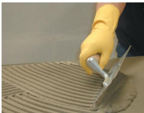
Aplicação do Mapetherm AR1 no reverso do painel com espátula dentada
