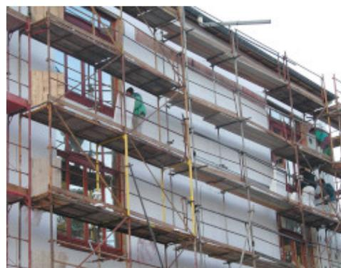
Colagem dos painéis termo-isolantes na fachada com Mapetherm AR1
