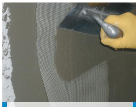
Barramento dos painéis termo-isolantes armada com rede em fibra de vidro inserida na camada de Mapetherm AR1
