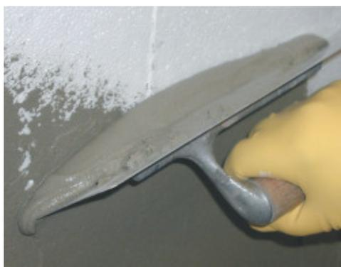
Barramento dos painéis termo-isolantes: aplicação do Mapetherm AR1
