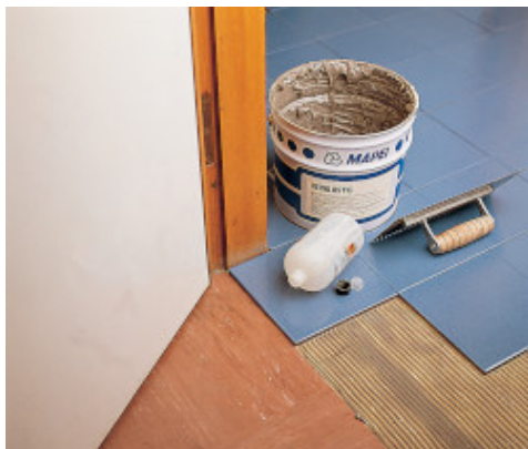
Assentamento sobre pavimento velho em PVC
